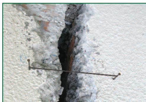
Sl. 54. Praćenje pomjeranja na pukotini na objektu
