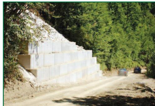
Sl. 71. Trajno saniranje potpornim konstrukcijama
