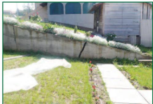
Sl. 39. Smicanje i razmicanje potpornog zida
