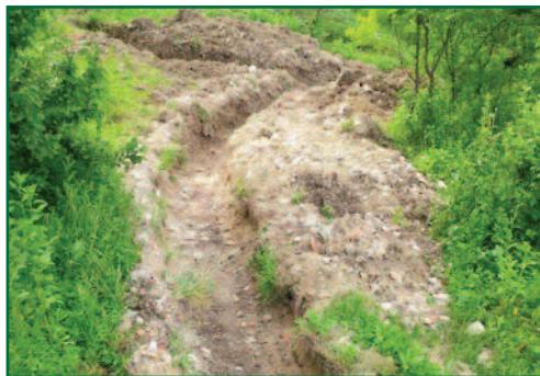
Sl. 81. Bočni drenažni kanali
