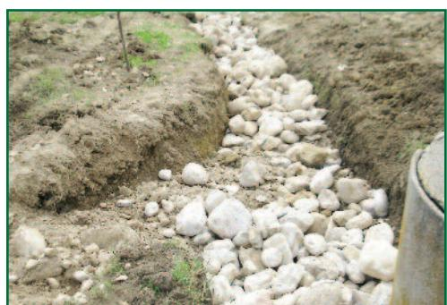
Za prikupljanje podzemnih voda rade se drenažni rovovi. To su duboki rovovi u kojima se nalaze perforirane cijevi prečnika 200-300 mm. Ispunjavaju se, od donjeg dijela prema gore šljunkovitim, pjeskovitim materijalom i zemljanim zasipom (slika 84).
